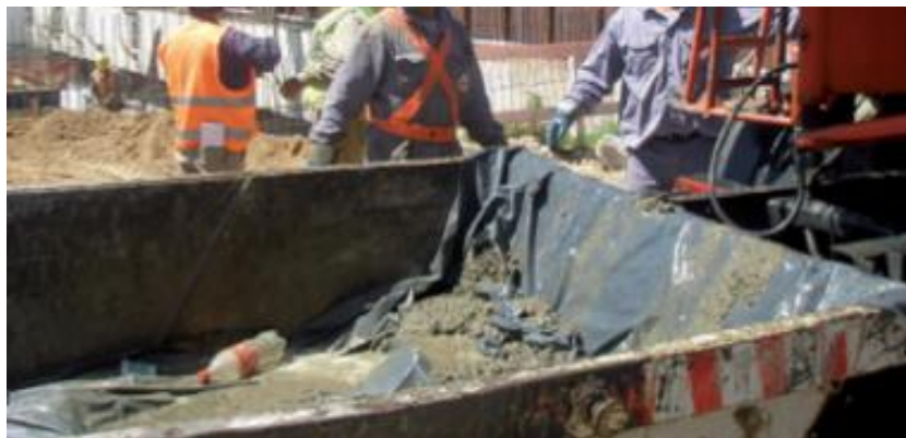
Imagen 46: volquete durante la limpieza de sobrantes de hormigón
