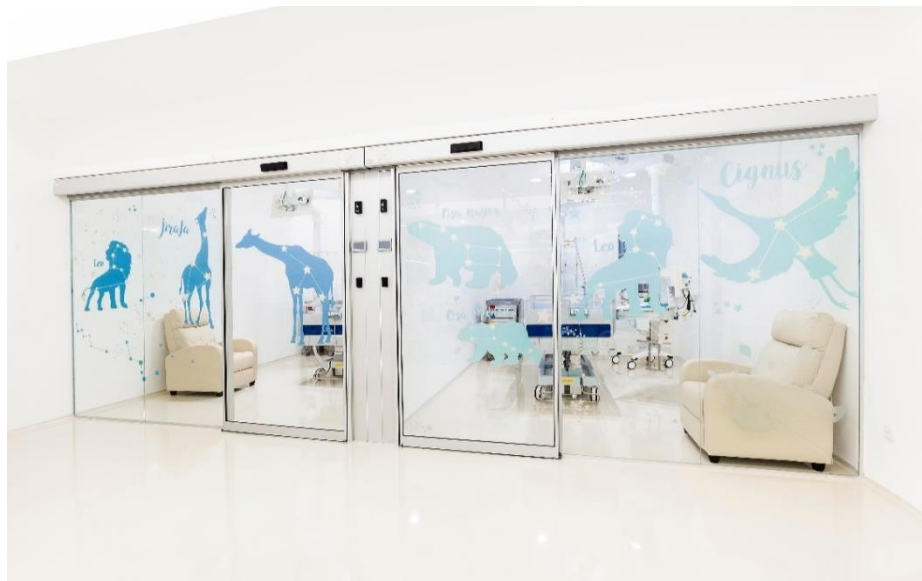
Foto: Imagen de salas de presión, uci, vinílico en el cerramiento vidriado. Fotos extraídas de la pagina https://www.comunidad.madrid/hospital/ninojesus/profesionales/servicios-medicos/cuidados-intensivos-pediatricos . "Hospital Infantil Universitario Niño Jesús"-Salud Madrid
