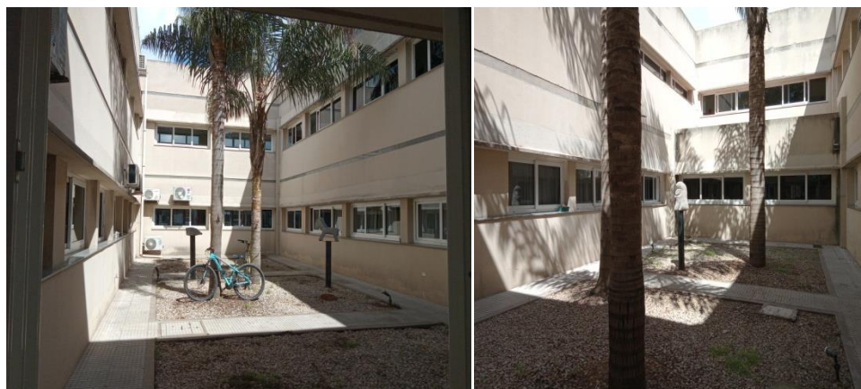
Imágenes: patios internos que proporcionan iluminación natural y visuales a los ambientes que los rodeas, administración y consultorios en planta baja, internación y terapia en planta alta.
