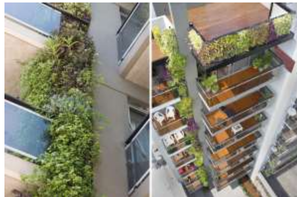
Foto 27 Edificio S1006 Curvan I, Quilmes
