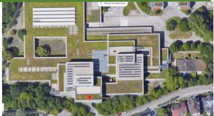
Foto 22 Cubierta Verde , Edificio Werner Siemens Schule
