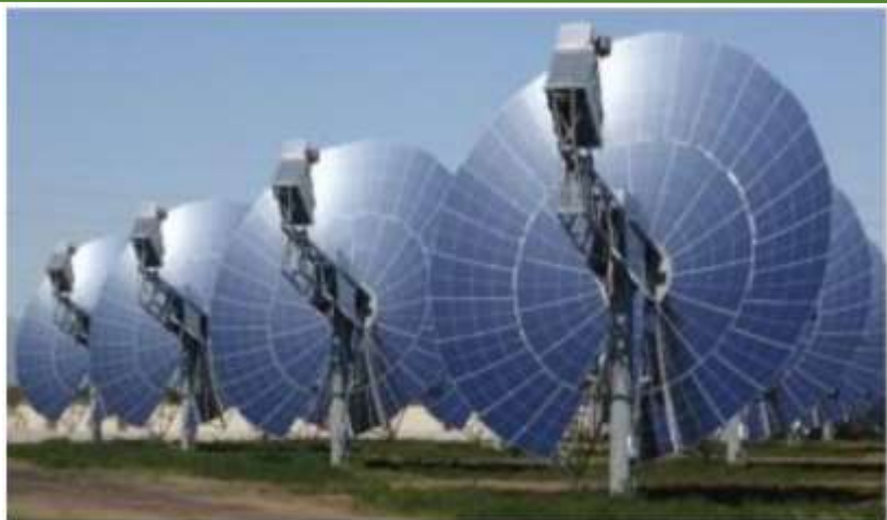
Foto 45 Planta Solar Térmica de Disco Parabólico
