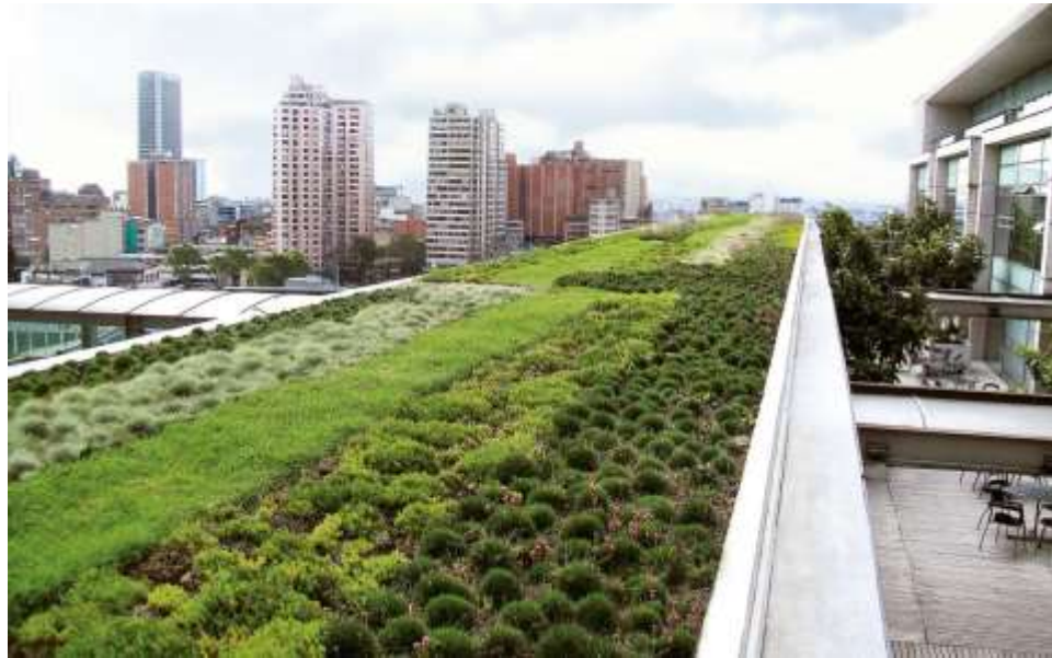
Foto 38 Cubierta Vegetal Extensiva
