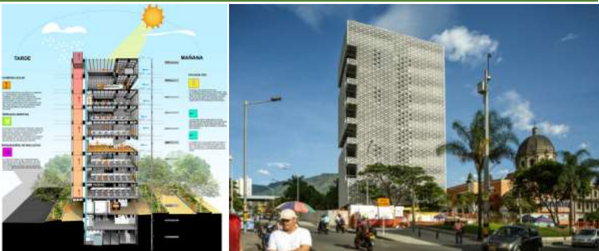
Foto 11 Ventilación Natural, Nueva Sede Empresa de Desarrollo Urbano, Medellin
