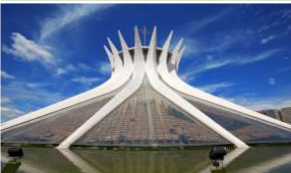
Foto 14 Enfriamiento Evaporativo, Catedral de Brasilia, O. Niemeyer
