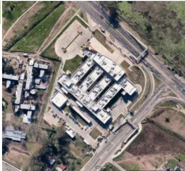
Foto 31 Hospital Balestrini y su entorno vegetal, estado actual
