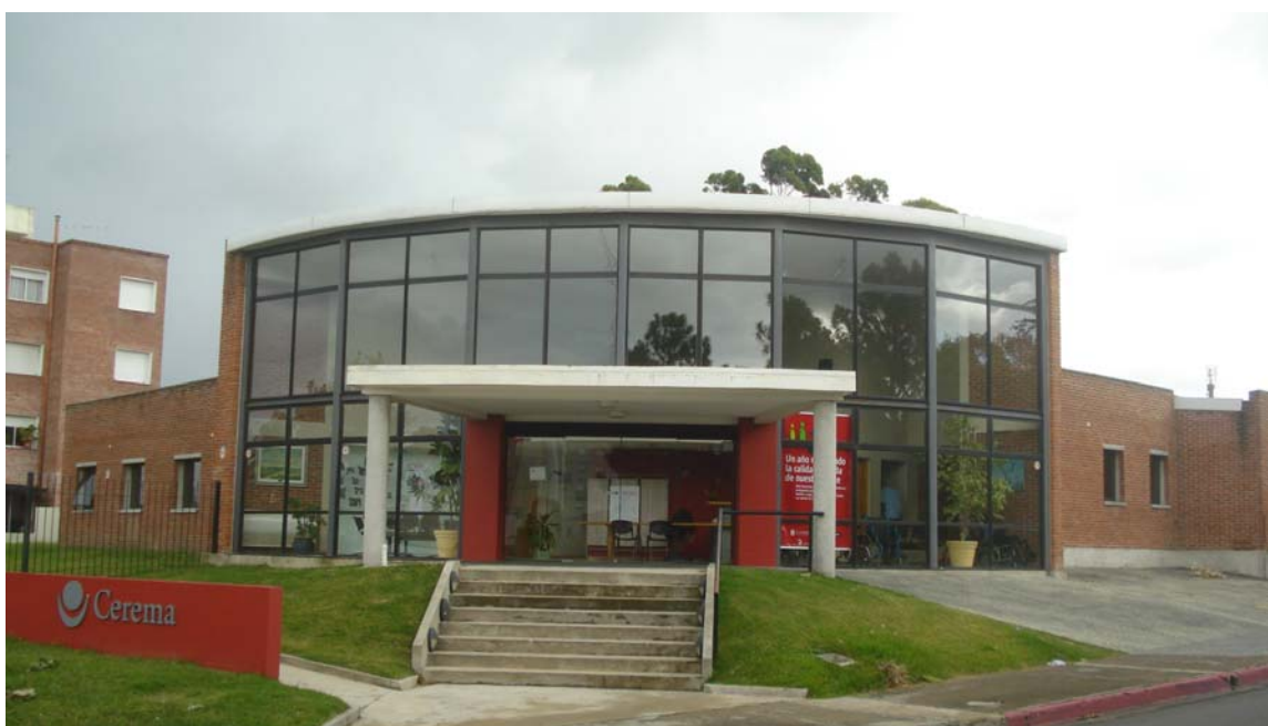
Foto N° 2: Fachada principal del edificio
