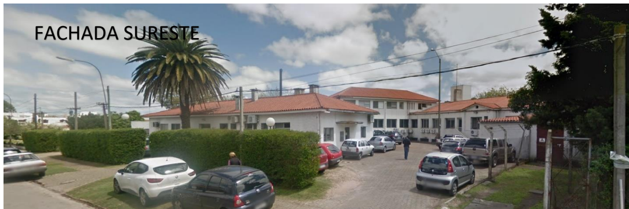
Figura 7 y 8, vistas exteriores del centro quirúrgico. Imágenes sacadas de Google earth.
