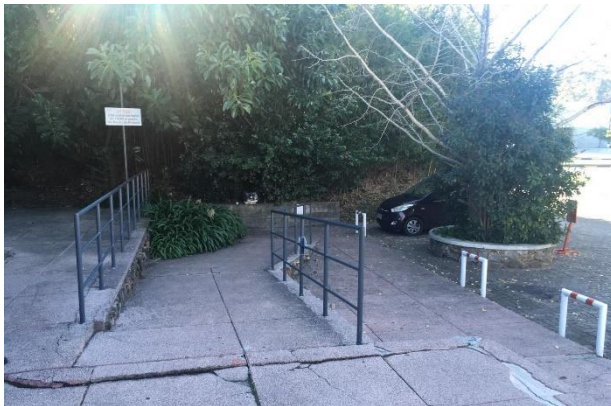
Figura 14, rampas de acceso al público del centro quirúrgico.
