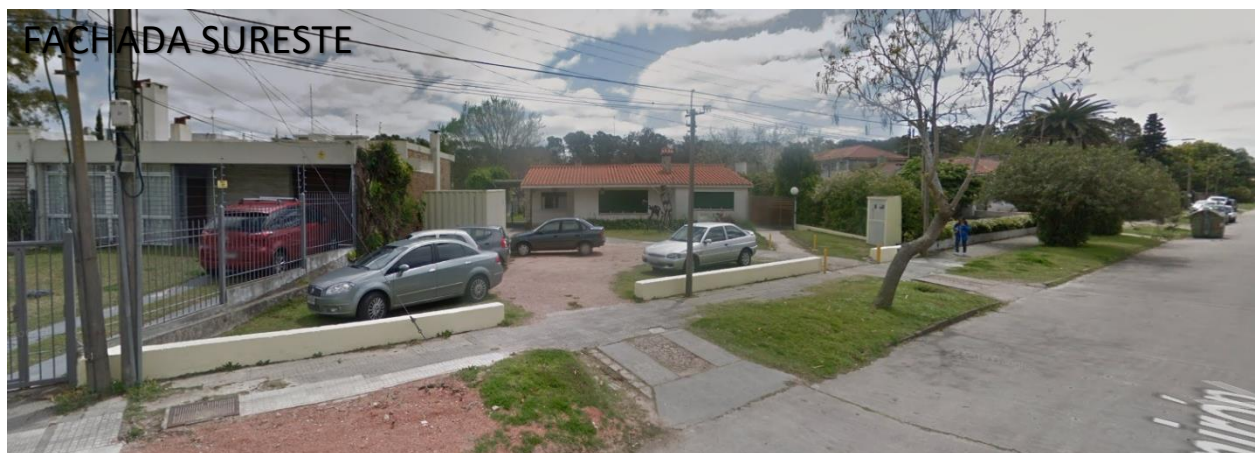
Figura 4, 5 y 6, vistas exteriores del centro quirúrgico. Imágenes sacadas de Google earth.
