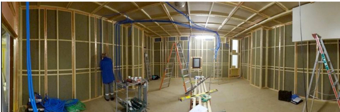
Foto N°1: Sala de Imagen de Resonancia Magnética en Construcción
